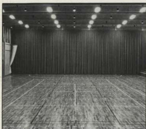
Kjelleruphallen: Sylvaket Standard lagt i eksisterende hal, hvor tidligere belægning skulle udskiftes.
